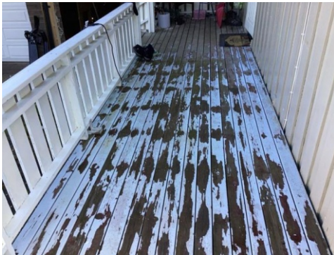
Eksempel på råteskade
