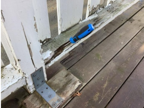
Eksempel på råteskade
