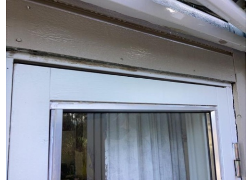
Eksempel på manglende beslag
