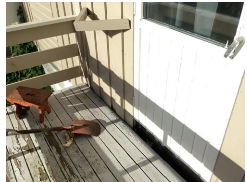
Eksempel på manglende beslag
