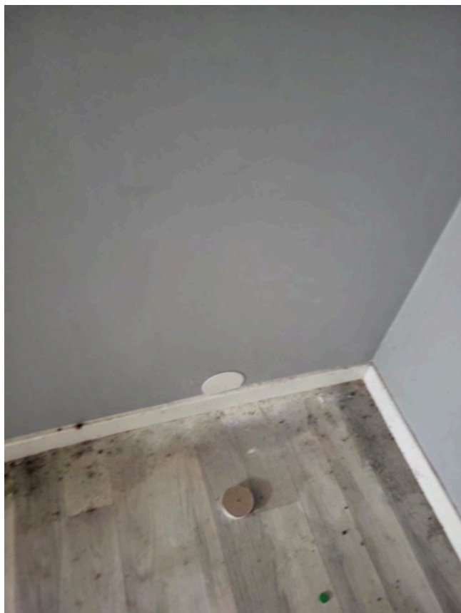
Hulltaking i en utforet vegg.
