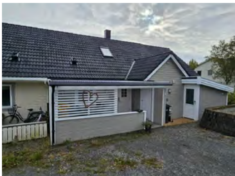
Takoverbygg ved inngang
