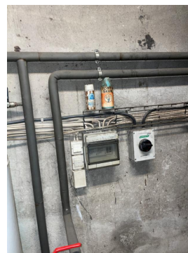
kappet ledning under sikringskap
