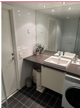
Gulvvarme og opplegg for vaskemaskin på badet.
