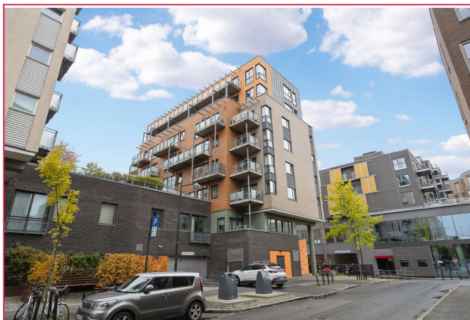
Leiligheten ligger fint til i byggets andre etasje og har fransk balkong mot omgivelsene
