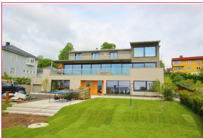
Fasade, inngangen til leiligheten er på baksiden.
