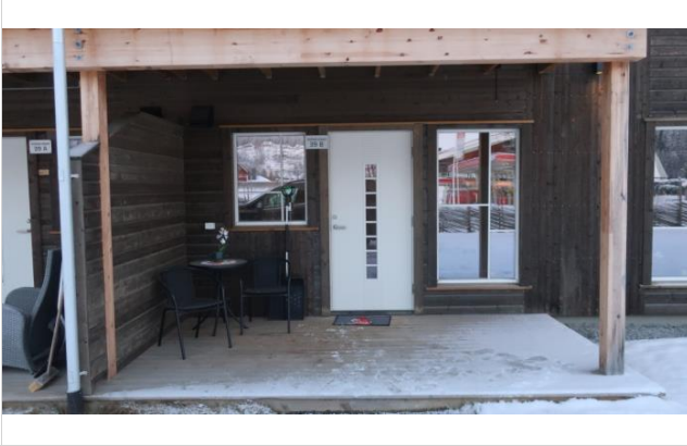
Overbygget inngangsparti og terrasseplattning.
