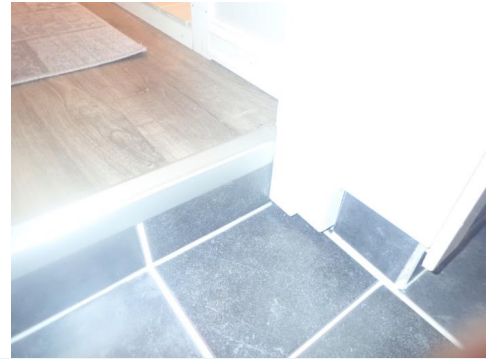
Nedsenket badegulv. med betongsokkel mot de andre rom.
