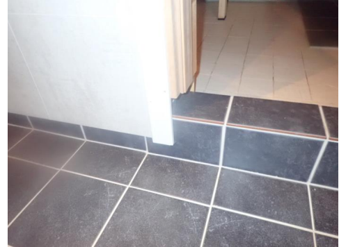
Nedsenket badegulv. med betongsokkel mot de andre rom.
