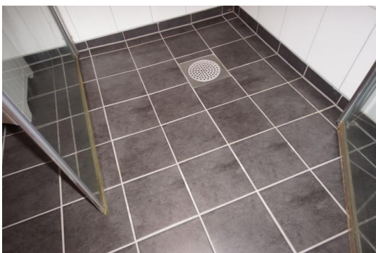
Fliser på gulv i Dusj/Wc/Vask rom.
