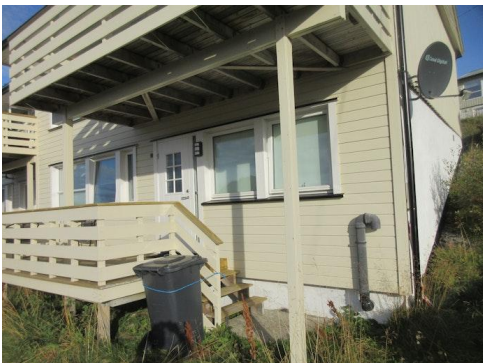
Ventil i ringmur, via "svanehals"
