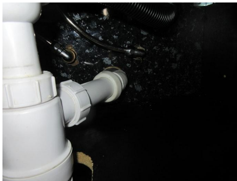
Gjennomføringer i vegg uten mansjett.
