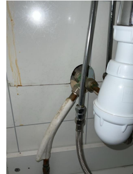
Utett rørgjennomføring i vegg under servant
