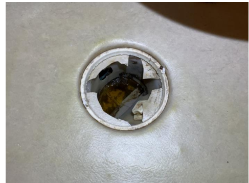
Utett rørgjennomføring i vegg under servant
