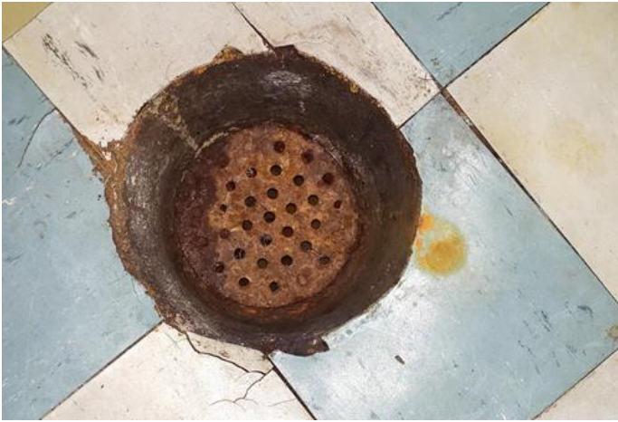
Våtrom - [Sluk hoveddel]
