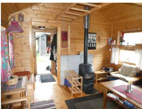
Det er registrert skjevheter i gulv på eldste del og i tilbygg.
