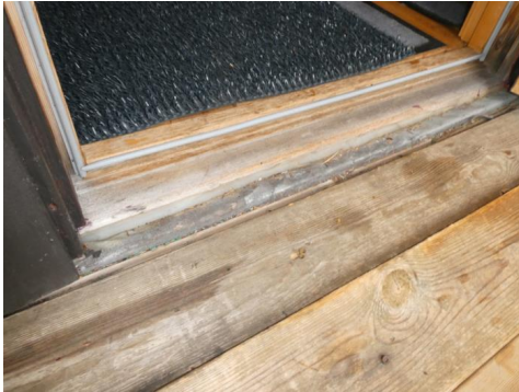
Utførelse med tetting og beslag, er ikke helt fagmessig utført.
