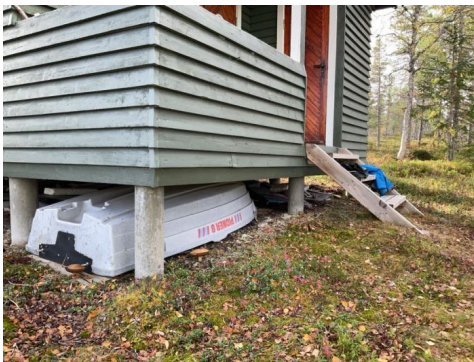
Fundamentering av betongpilarer.
