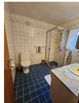
Sluk, ikke observert membran/tetting i sluk
