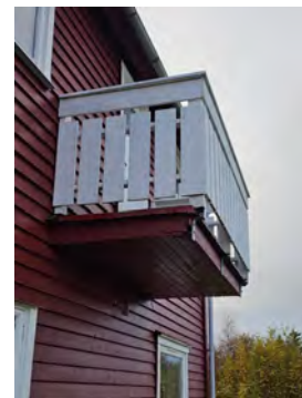
Råteskader på balkong på loft
