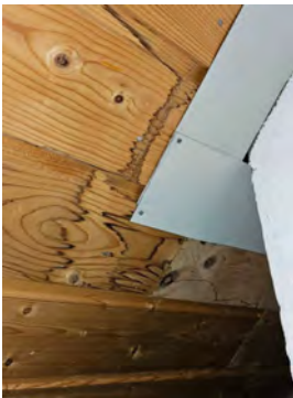
Fuktsjolder ved pipe, tørrt ved befarings
