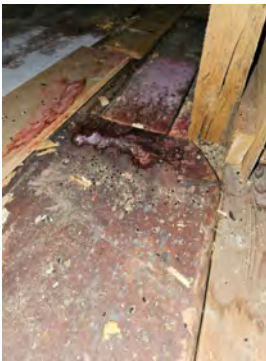
Fuktsjolder ved pipe, tørrt ved befarings
