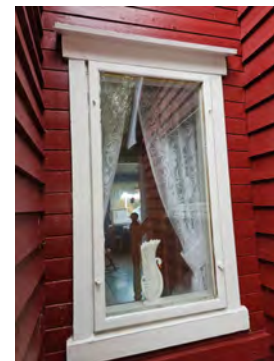
Vindu med enkelt glass, ikke metallbeslag over vindu
