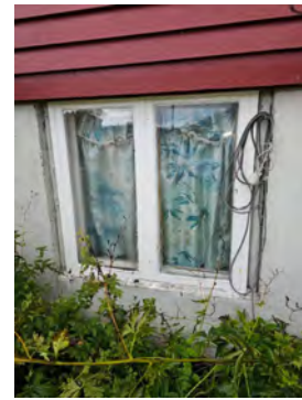
Kjellervindu med koblede glass uten metallbeslag under
