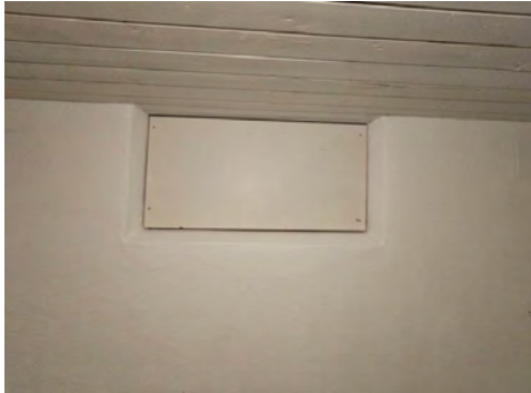
Mulig luke til krypkjeller under bad
