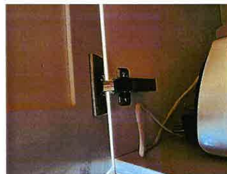
Slitte hengsler over microbølgeovn HOVEDETASJE > KJØKKEN/SPISEPLASS
