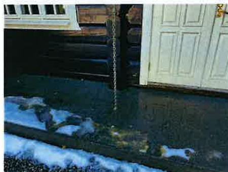
Kjetting som nedløp leder vann til betongplatt
