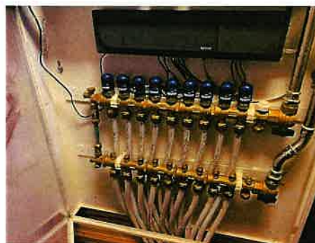
Fordeleskap for vannbåren varme
