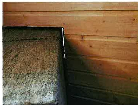
Utett pipegjennomføring
