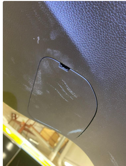
3.1 Skadet/merker etter utstyr
