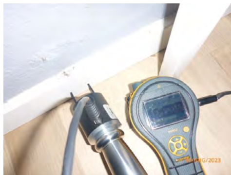
Toalettrom i kjeller
