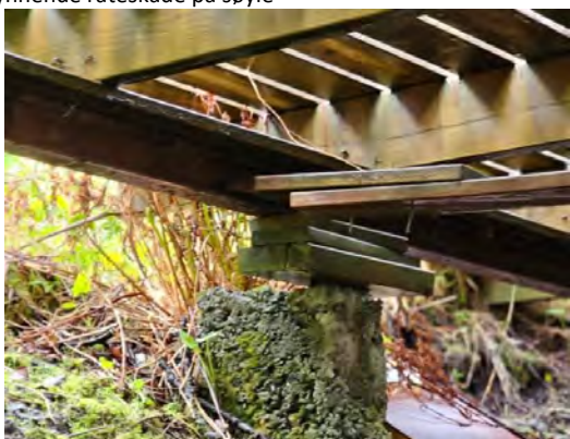
Stabling av trevirke under bærebjelke
