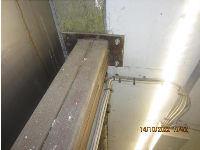
Stålbjelke over dør mot gårds plass
