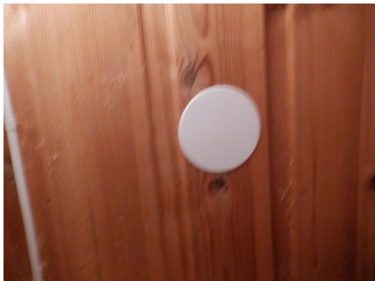
Plombert hull etter hulltaking.
