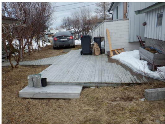
Platting foran inngangsparti.
