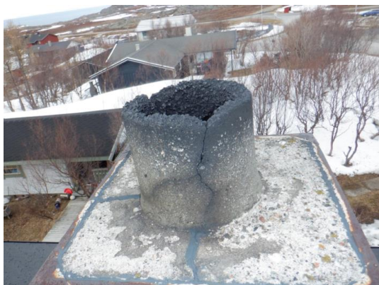
Innerrør i pipe på tak.
