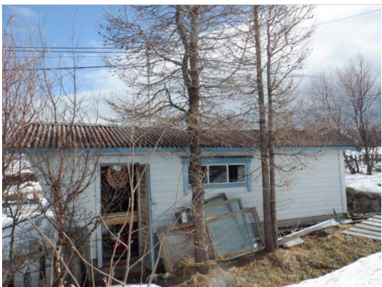
Garasje med dør og vindu.
