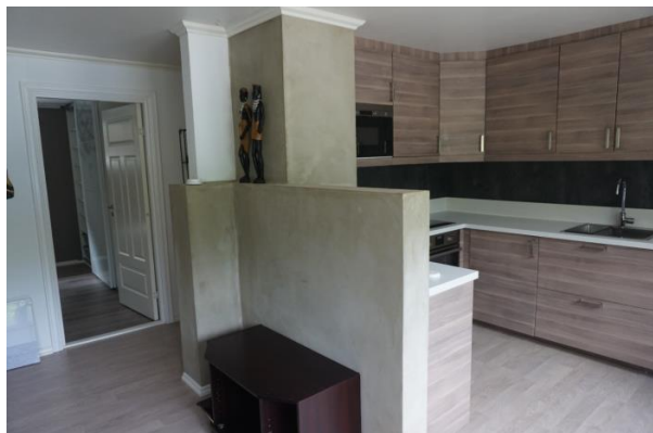
Pipe og brannmur.
