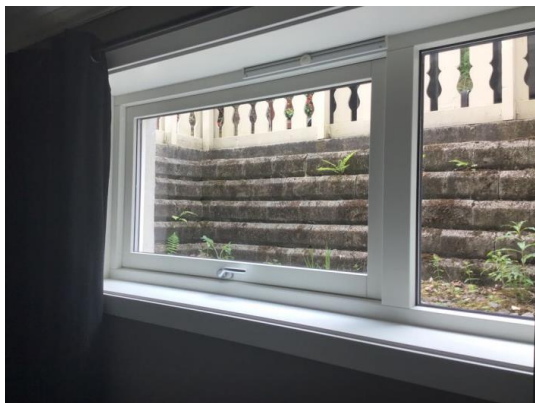
Vinduer fra innsiden.
