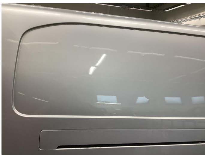
1.2 Generelt mye bruksslitasje
