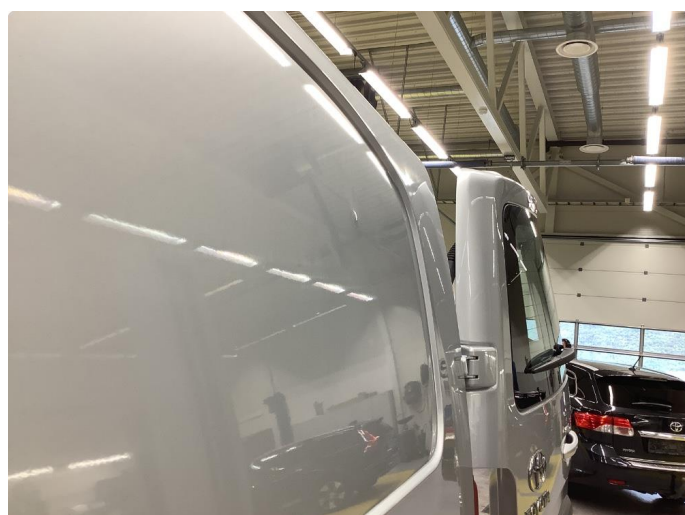
1.2 Generelt mye bruksslitasje
