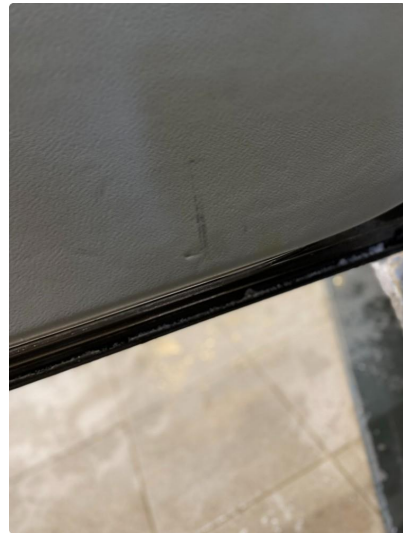
2.1 Skadet/merker etter utstyr
