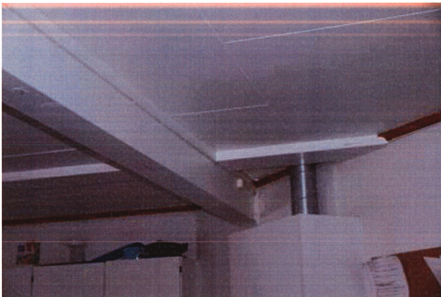
Gitterdrager (innkasset) krysser over limtre drager.
