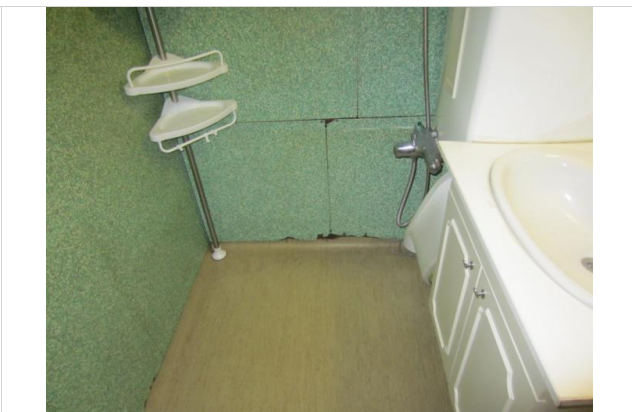
Fuktskade vegg
