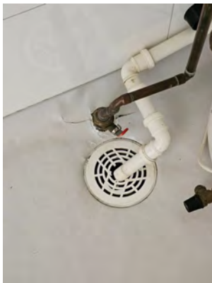
Sprekk i belegget ved vanninntak
