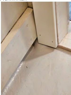
Sprekk i belegget ved vanninntak
