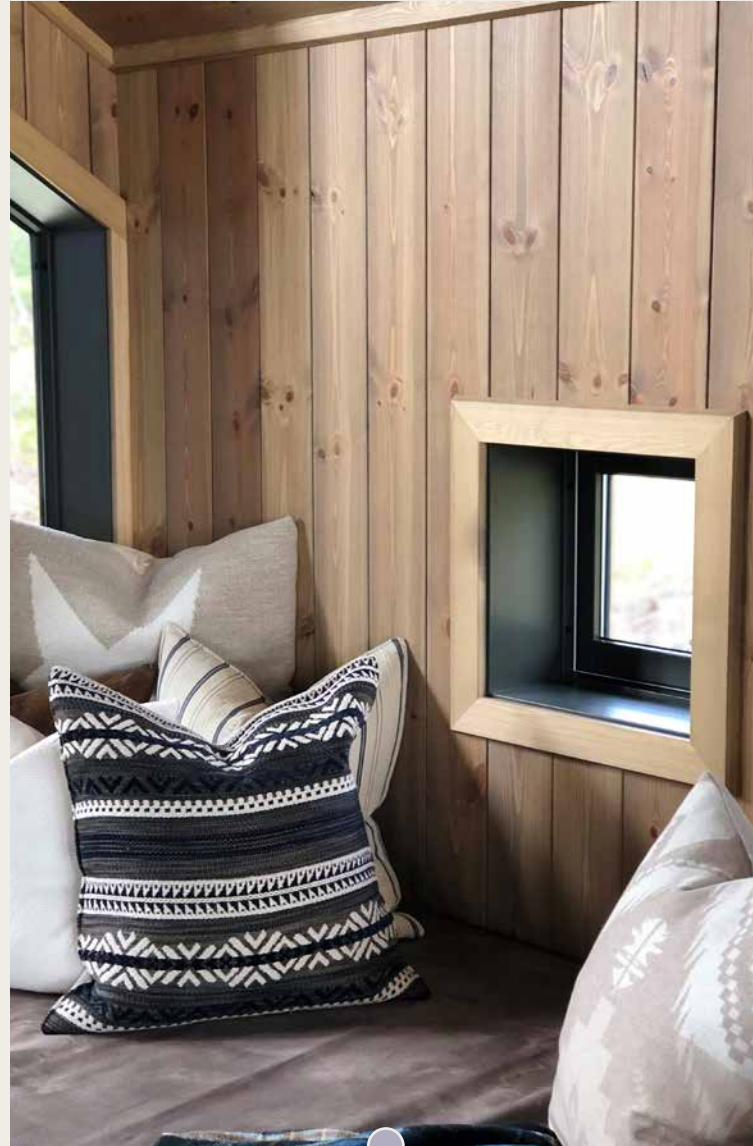
Vindusforinger Heltre furu malt i samme farge som vindu. Bomull NCS S0502-Y er standard vindusfarge.
