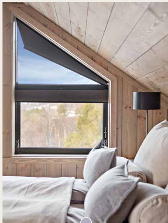
Vindusforinger Heltre furu behandlet som veggpanel
