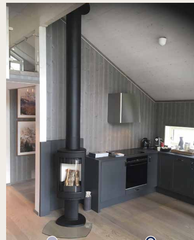
Stålpipes Isolert stålpipes. Takstige inkludert
