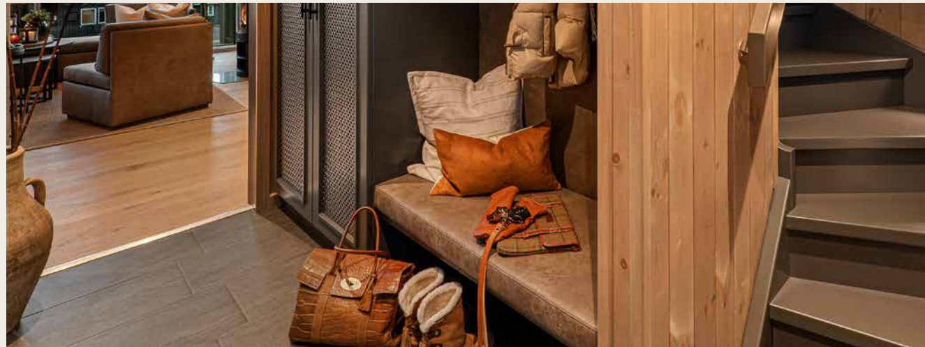
Panel vegg og himling: Furu sprekkpanel beiset: skigardsgrå. Listverk: Furu tidløs listverkserie, beiset: skigardsgrå. Flis: Softbeton mørk grå 30x60 Trapp: Malt NCS S7500-N Garderobe: Bakkens Treprodukter
