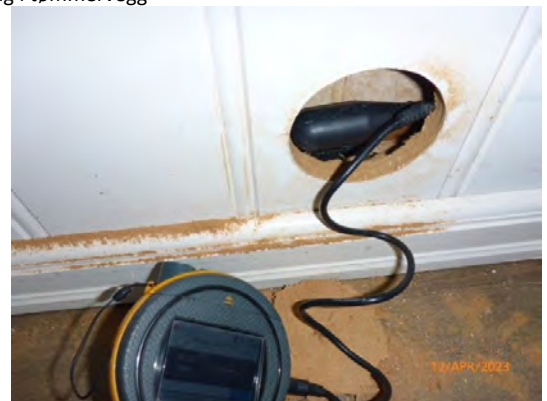
Måling i utforing på tømmervegg
