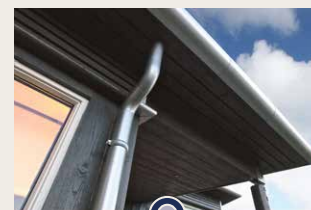
Nedløp for vann Integrert i takkonstruksjonen.
