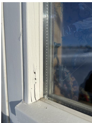
Vedlikeholdsbehov av vinduer
