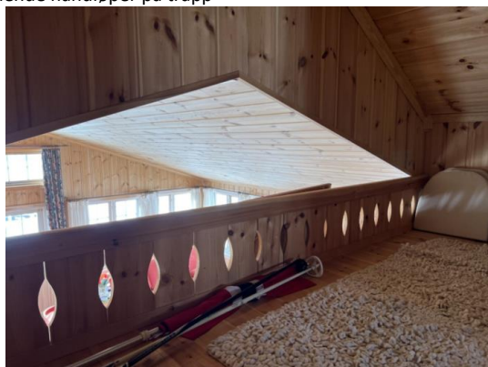
For lav rekkverkhøyde ihenhold til krav om høyde på rekkverk
