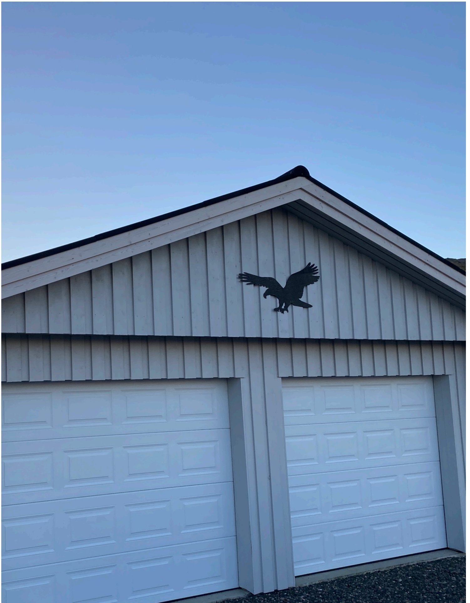
Utvendige forhold garasje og enebolig
