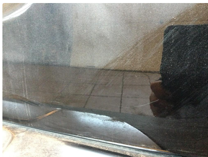
1.1 Generelt mye bruksslitasje
