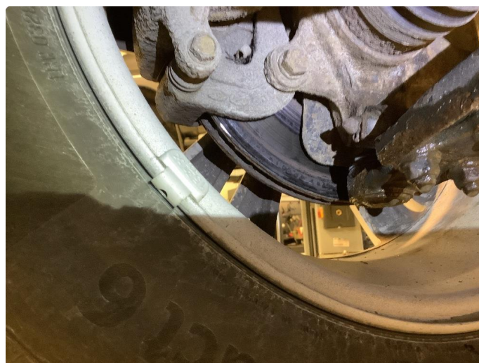
5.3 Mer enn 25% rust, skiftet
