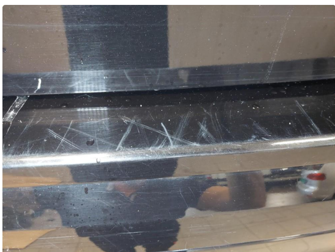
1.3 Ripe(r) ned til grunning
