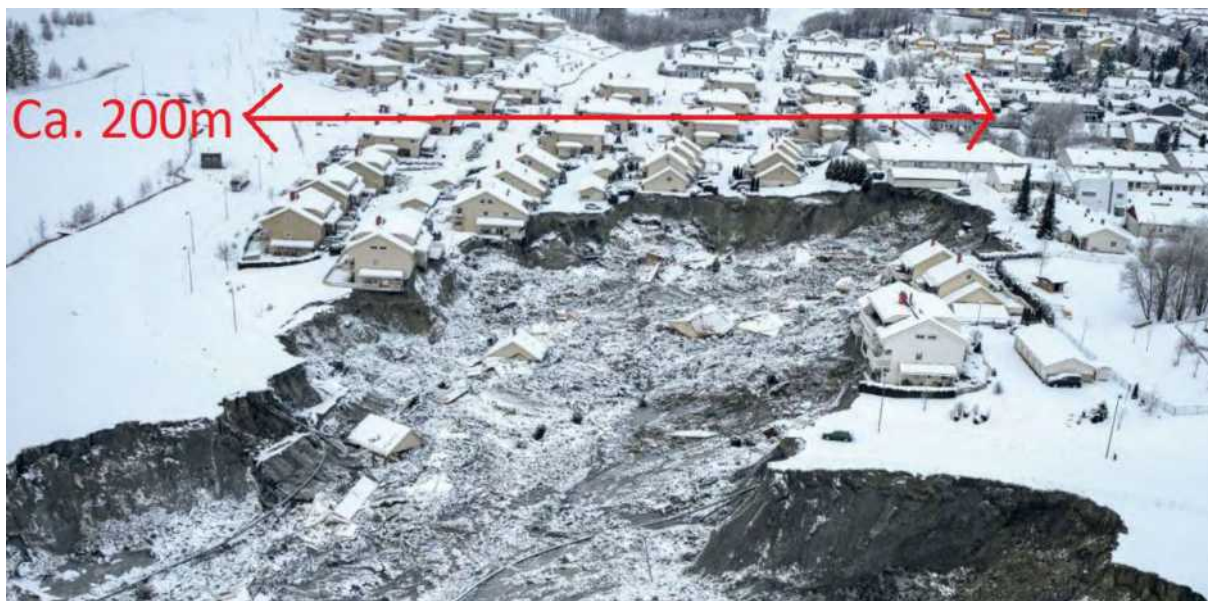
Figur: Løsneområde (retrogressjonsområdet) i Gjerdrum. Gorm Kallestad / NTB.
