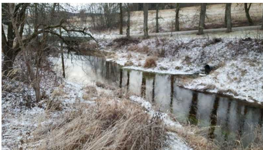
Fig. 8: Bekk på vestsiden av vei 328 Ekebergveien. Ca. kote ved vannkant er +145 m.o.h.
