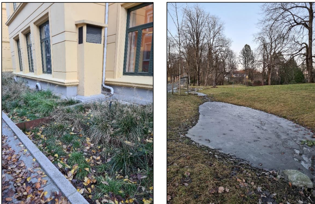
Figur 12: Åpen håndtering av overvann. Til venstre: Takvann som ledes til et regnbed, og til høyre en åpen fordrøyningsdam.
