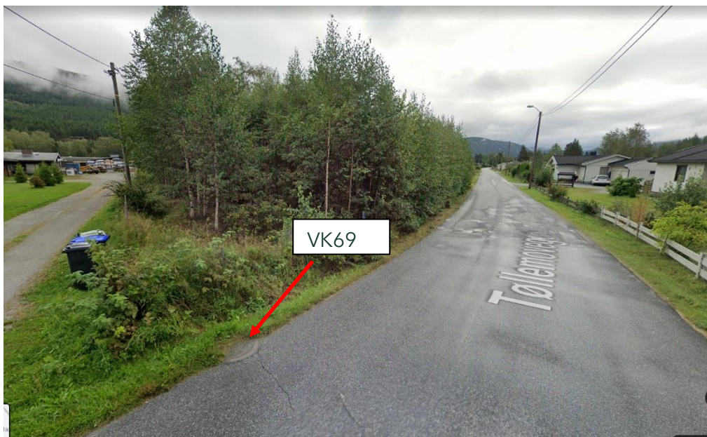
Figur 4: VK69 i Tøllemovegen. Denne må skiftes ut med en ny kum. Kilde: Google streetview
