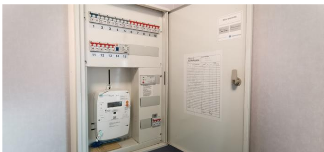
Kontroll av el-skapet.
