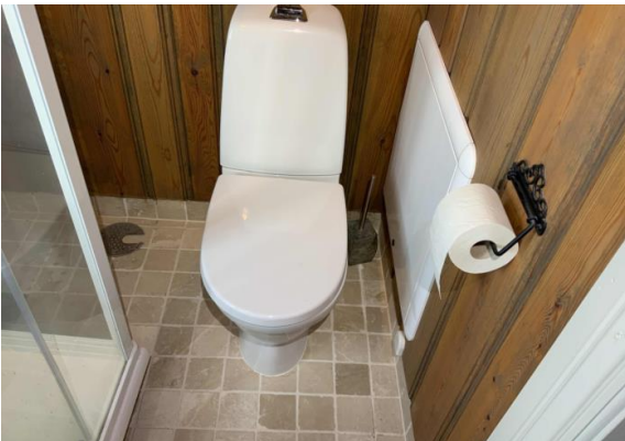
wc og rør skap inne på bad
