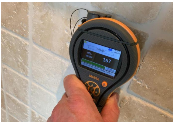
Vegg rett under blandebatteri i dusjsone
