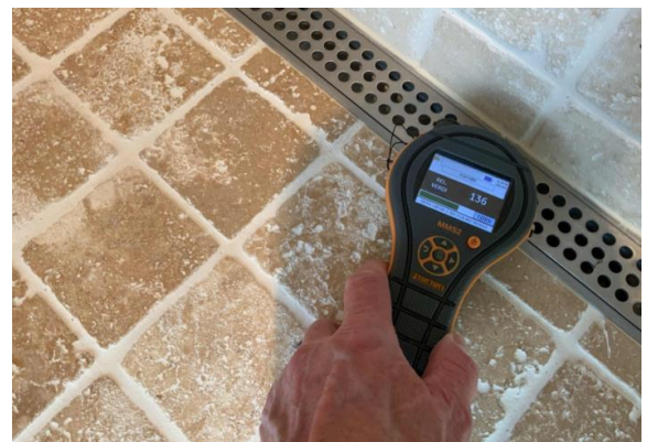
Fuktmåling rundt sluk i dusj.
