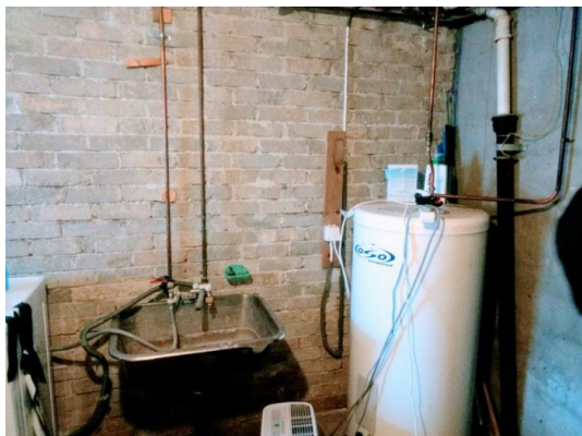
Foto av deler av vaskerom i Nyheim 1
