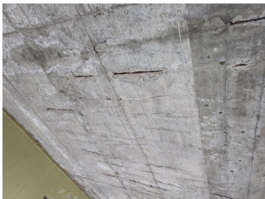
Nyheim 1: Underside av altanplate
