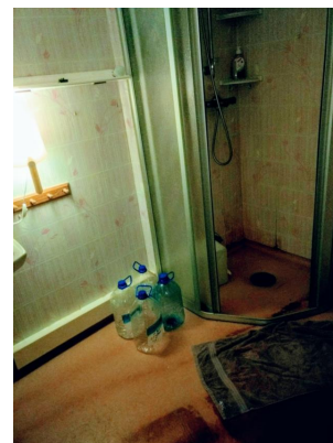
Foto av Dusjrom i kjeller Nyheim 1
