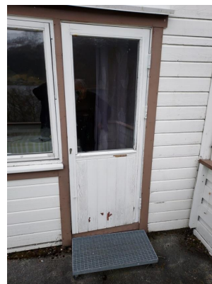
Vindu og balkongdør fra stue til altan på Nyheim 1
