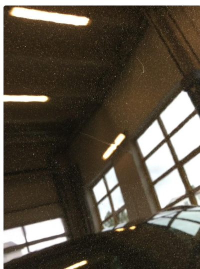
2.1 Noen riper og småbulker
