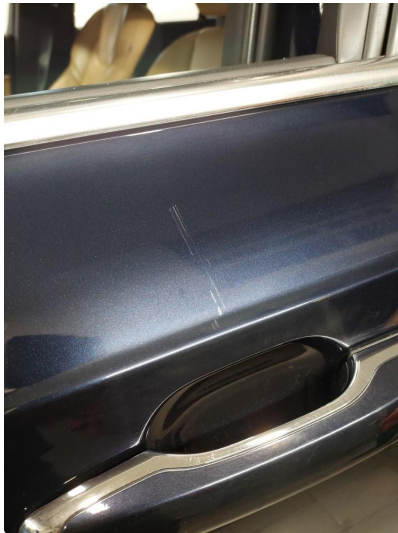
1.1 Ripe ned til grunning
