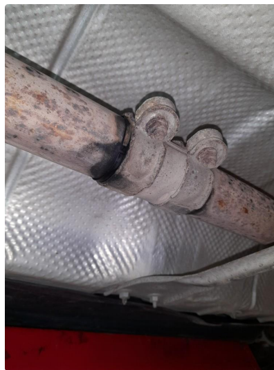
3.1 Ok reparert. eksoslekkasje
