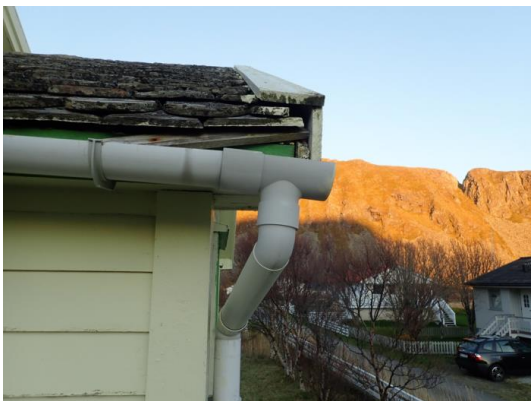
Tak over inngangsparti
