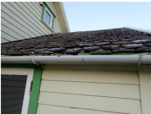
Tak over inngangsparti
