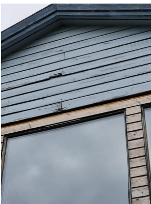
Spredte råteskader i nerkant av kledning
