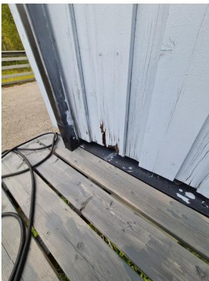
Spredte råteskader i nerkant av kledning
