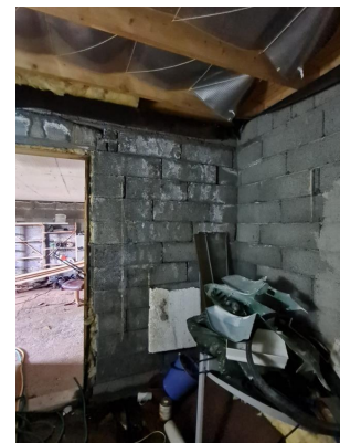
Vegg mellom bolig og tilbygget balkong.
