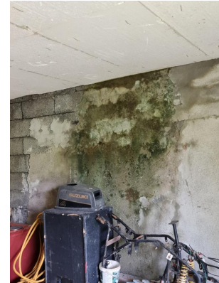
Vegg mellom bolig og tilbygget balkong.
