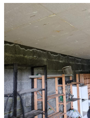
Yttervegg i tilbygget balkong
