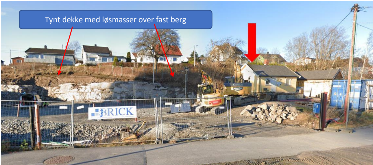
Figur 7: Synlig fjell i dagen, med beliggenheten av tiltaksstedet markert med en rød pil i skråningen bakenfor det gule huset (Google, 2022).
