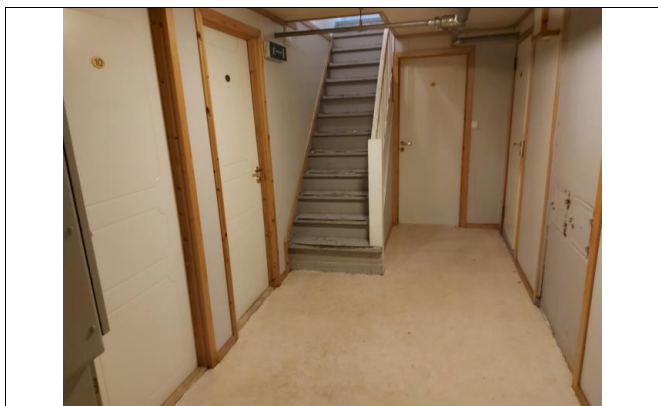
Trapp fra kjeller til 1.etg på østfasaden.
