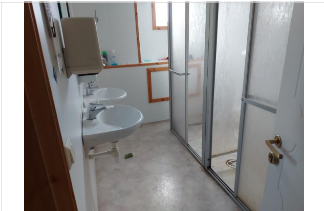
Felles dusjrom med toalettrom
