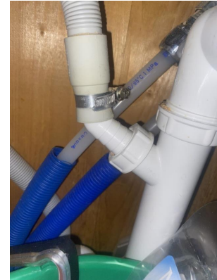
Mangler stedvis tettemuffe i overgang vannrør/varerør
