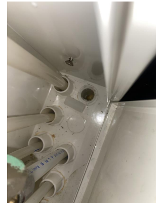
Mangler stedvis tettemuffe i overgang vannrør/varerør
