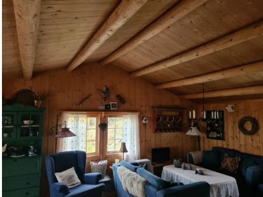
Saltakkonstruksjon. Synlige tømmeråser innvendig.
